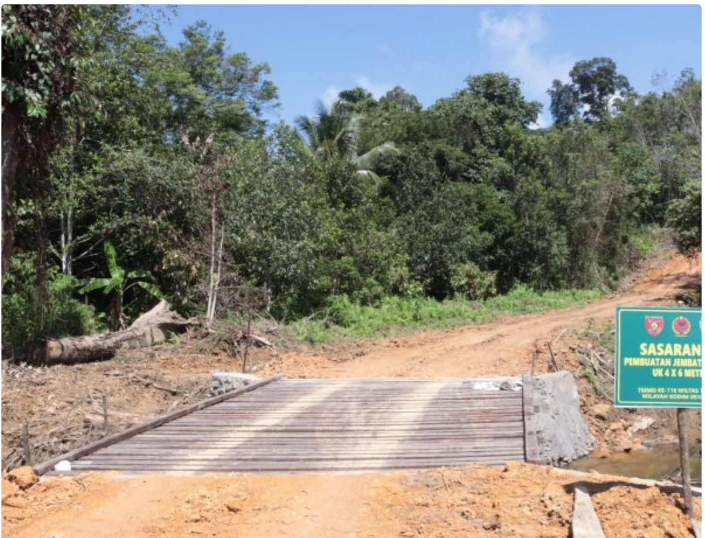
Progres Pembangunan Jembatan TMMD Ke-118 Wilayah Perbatasan Kodim 0910/Malinau Selesai 100 Persen
