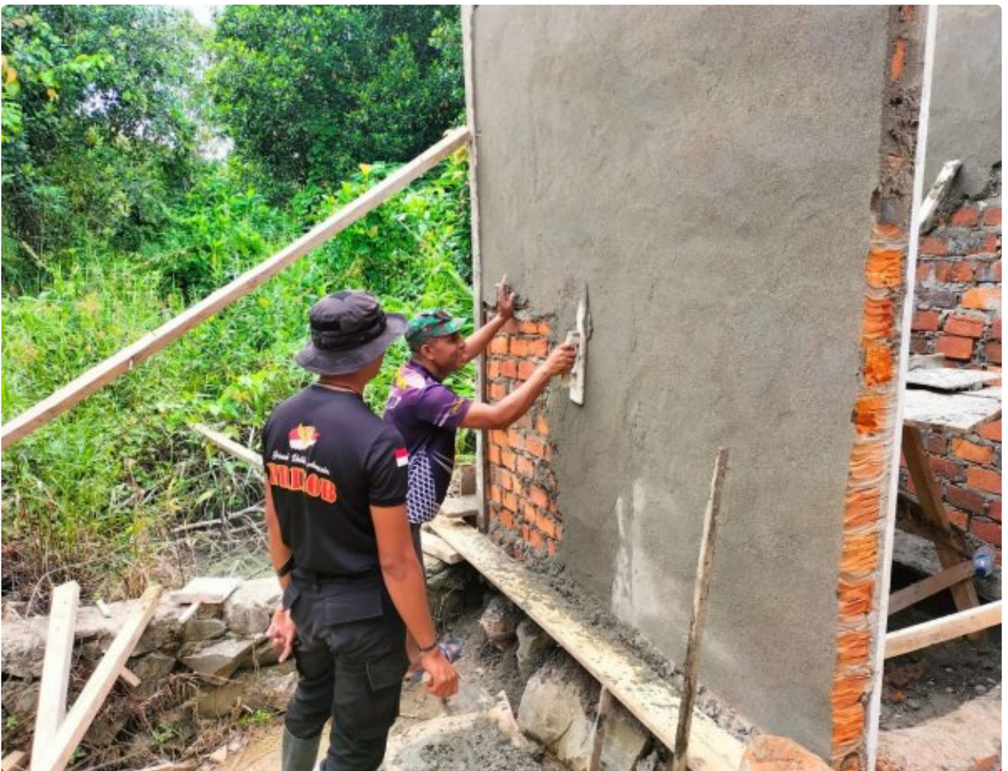
Satgas TMMD Ke- 118 Wiltas Kodim 0910/Malinau Plester Dinding Pembangunan MCK Gereja
