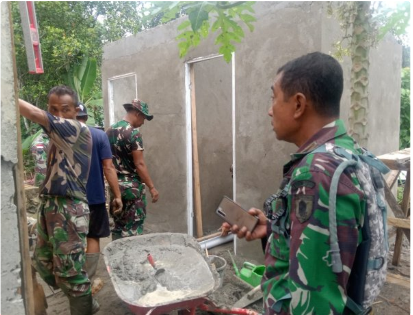
Wadan Satgas Tinjau Lokasi TMMD ke- 118 Sasaran Tambahan Pembuatan MCK Gereja.
